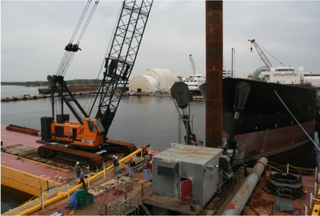
install dredge spud
